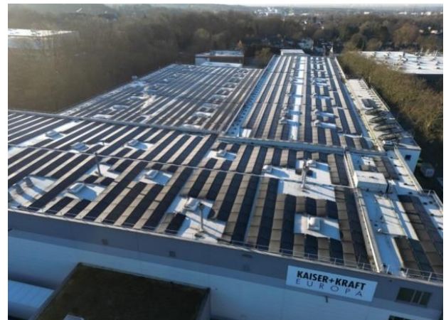
Mit 1,44 MWpeak Leistung wird die Photovoltaikanlage von kaiserkraft jährlich 1,39 MW klimaneutralen Strom produzieren: kaiserkraft.
