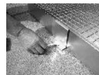
Vedi punto 7.1 Applicare il dispositivo di serraggio laterale e perforare il foro per il tassello
