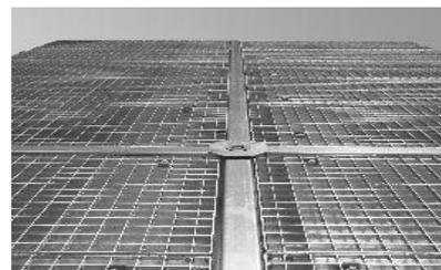
Pildil on toodu paigaldatud ristklamber.
