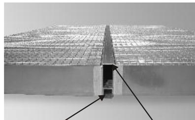
Montar peça intercalar & união da tina entre os dois elementos de plataforma.
