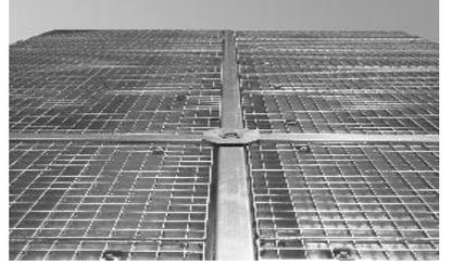
Montajı yapılmış çapraz bağlantı örneği.
