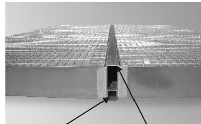
Afstandsstykke & karforbindelsesstykke monteres mellem to gulvelementer.
