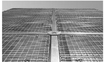
Exempelvy över en monterad kryssklämma.
