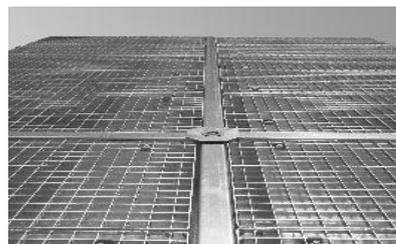
Immagine esemplificativa che illustra un dispositivo di fissaggio quadripolare montato.
