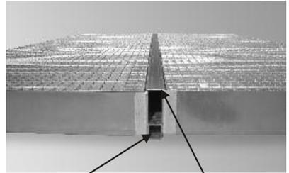
Distanzstück & Wannenverbinder zwischen beiden Bodenelementen montieren.
