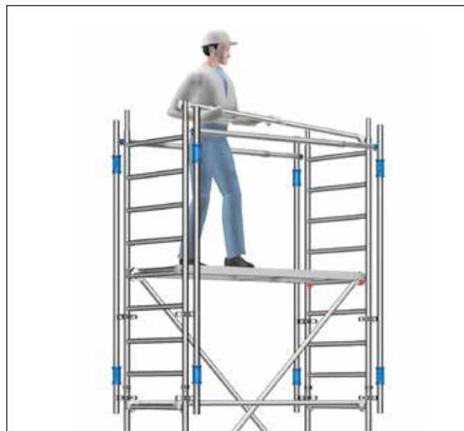
Fig. 6: Colocación segura de las barandillas con AGS
