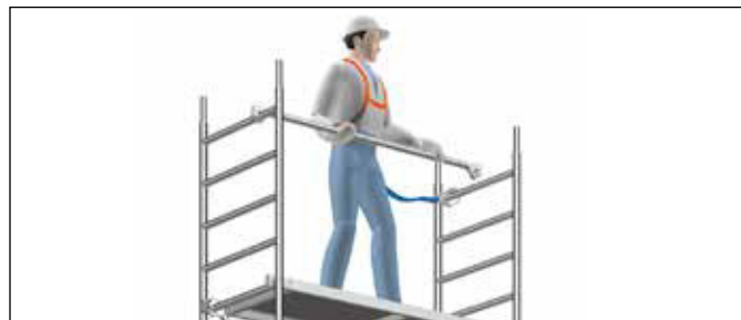
Fig. 3: Colocación de las barandillas con EPI
