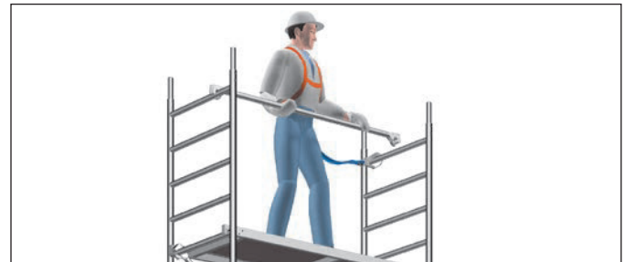
Bild 3: Sichere Montage der Rückenlehnen mit PSA
