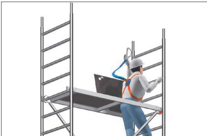
Bild 1: Anschlag der PSA während des Aufstiegs in die ungesicherte Lage
