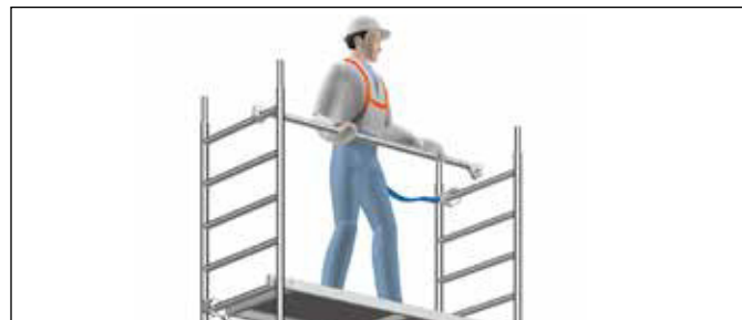
Fig. 3: Colocación de las barandillas con EPI
