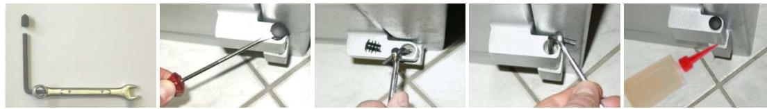
Per lubrificare le cerniere bisogna mettere un po' d'olio nella fessura tra la parte superiore e la parte inferiore della cerniera (Foto 5) ed eventualmente asciugare l'olio fuoriuscito.
